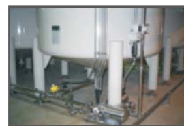
各業種に対応した仕様の 電気配線工事の施工例
